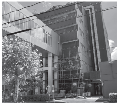
着々と復旧工事などが進む恵寿総合病院の様子(2024年7月)
